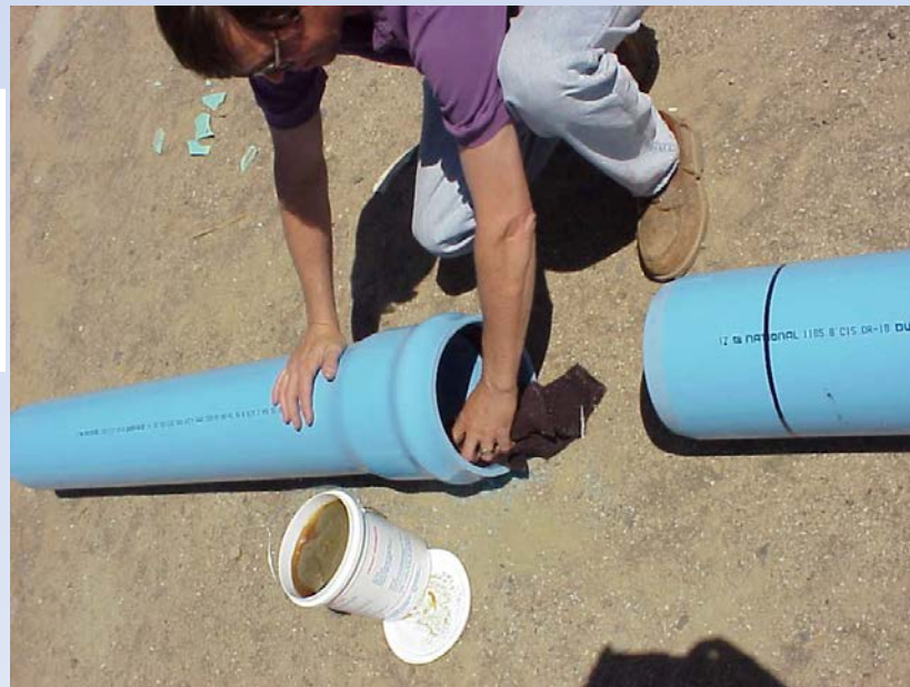
Priprema spoja tvrdih PVC cijevi
